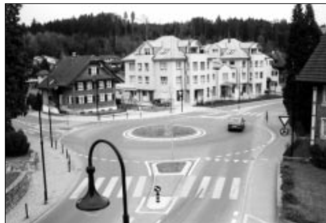
Abb. 1: In Inwil LU ersetzt ein Kreisel die frühere Kreuzung mit Lichtsignalanlage. Lärm- und Luftbelastung sind kleiner geworden.
